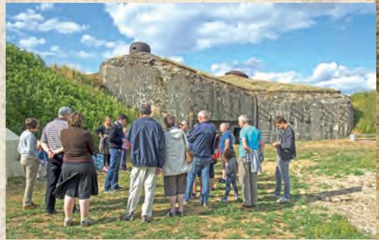
Ouvrage de la Ferté
